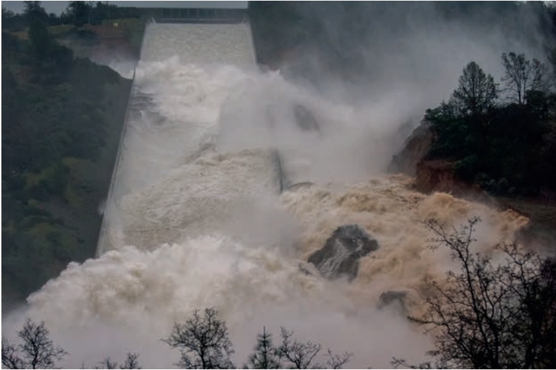
Abb. 3 Fortsetzung der Flutung, 9. 2. 2017, nachmittags. Die Überlauf Rinne wird „aufgegeben“. Der oberflächennahe Untergrund neben der Rinne wird zerrieben und färbt das Wasser orangebraun. (Foto/Credit: Kelly M. Grow/California Department of Water Resources)
